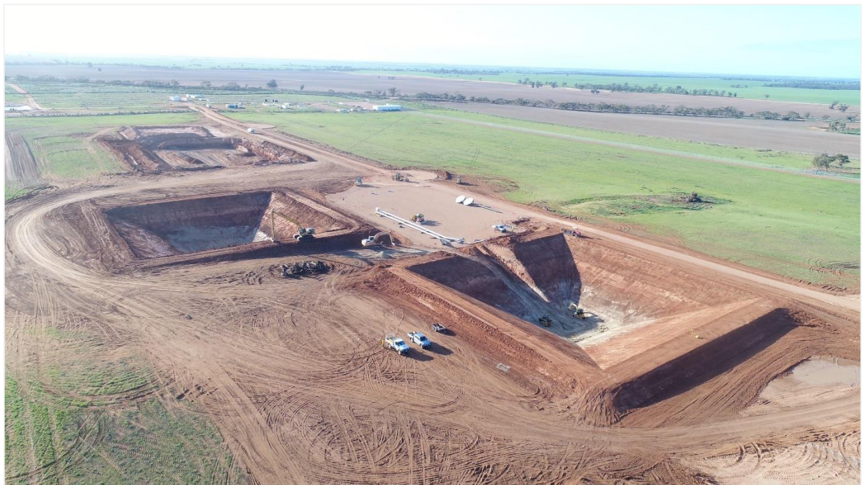
© RayGen Resources Pty Ltd 2021 – 50 MWh projekt ve výstavbě
