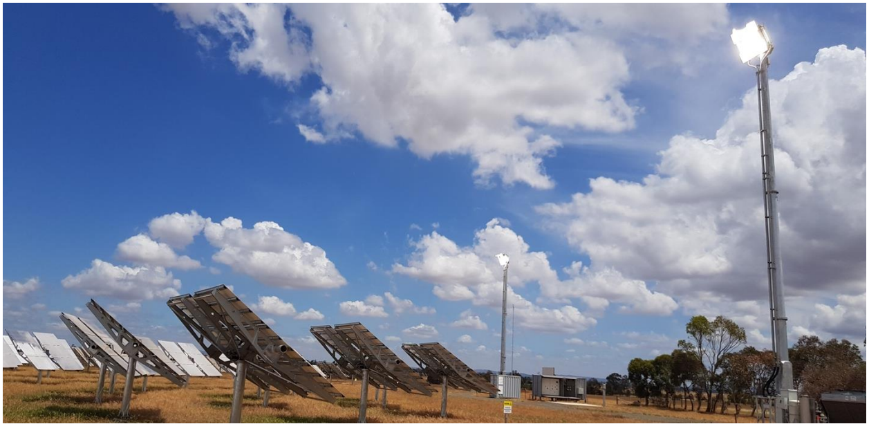
© RayGen Resources Pty Ltd 2021– Das einzigartige PV-Technologie der Firma RayGen
