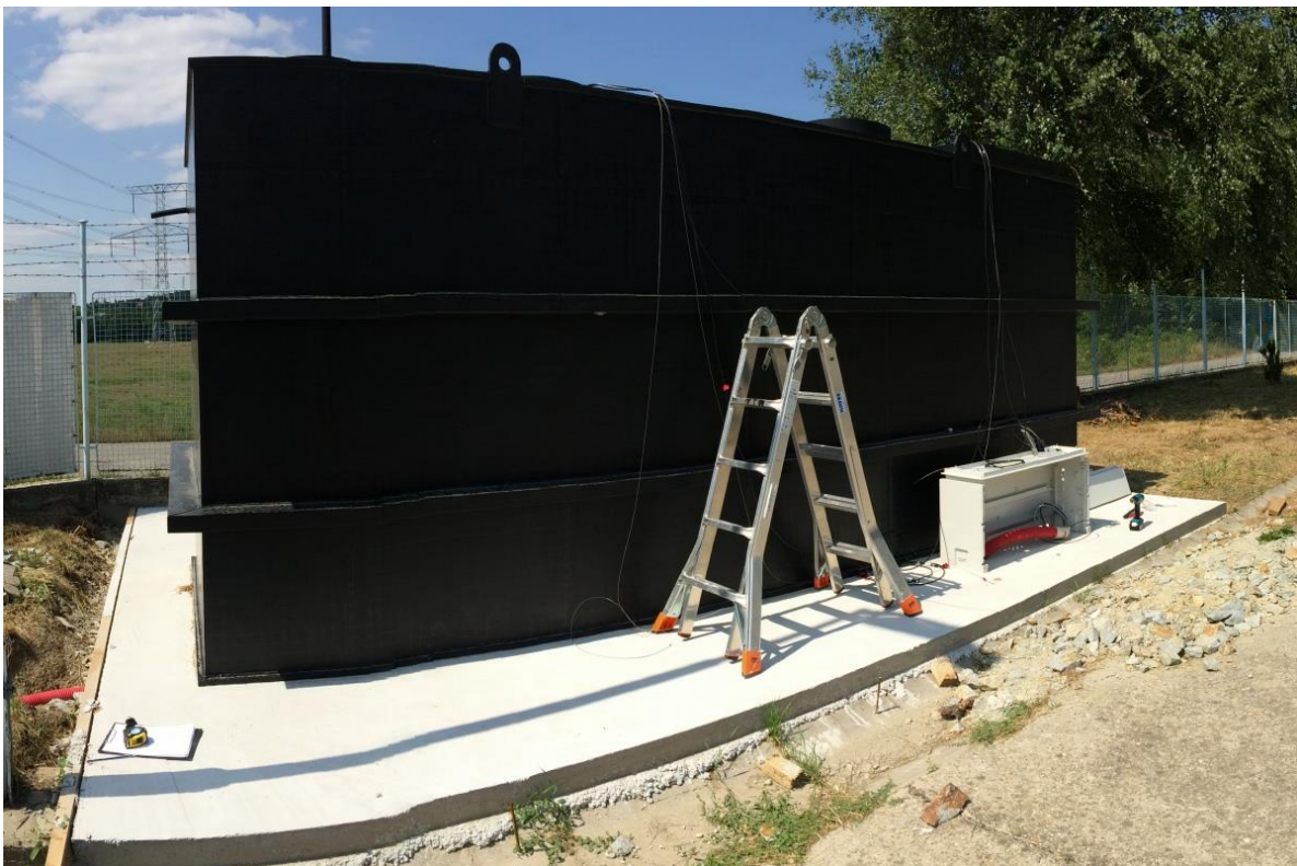
Modulová polypropylenová čistírna pro 50–300 ekvivalentních obyvatel (ilustrační obrázek, zdroj WYDREX s.r.o.)
